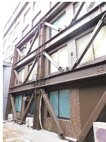
耐震補強されたこころのセンター中棟外観
